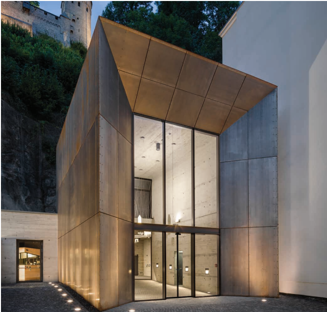
Aufzug Burg Altena – Torgebäude mit patinax®-verkleideter Außenhaut. Bildquelle: AMS GmbH, www.ams-mbt.de
