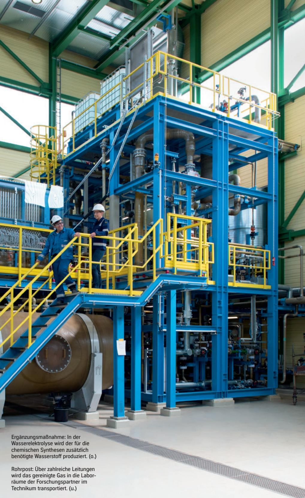
Ergänzungsmaßnahme: In der Wasserelektrolyse wird der für die chemischen Synthesen zusätzlich benötigte Wasserstoff produziert. (o.)
