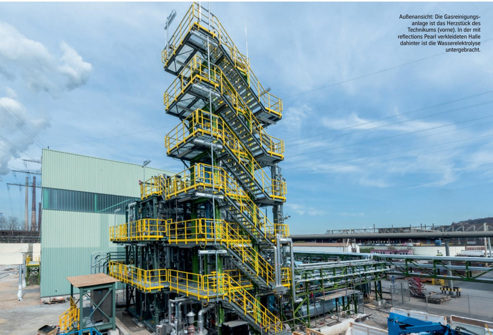
Außenansicht: Die Gasreinigungsanlage ist das Herzstück des Technikums (vorne). In der mit reflections Pearl verkleideten Halle dahinter ist die Wasserelektrolyse untergebracht.
