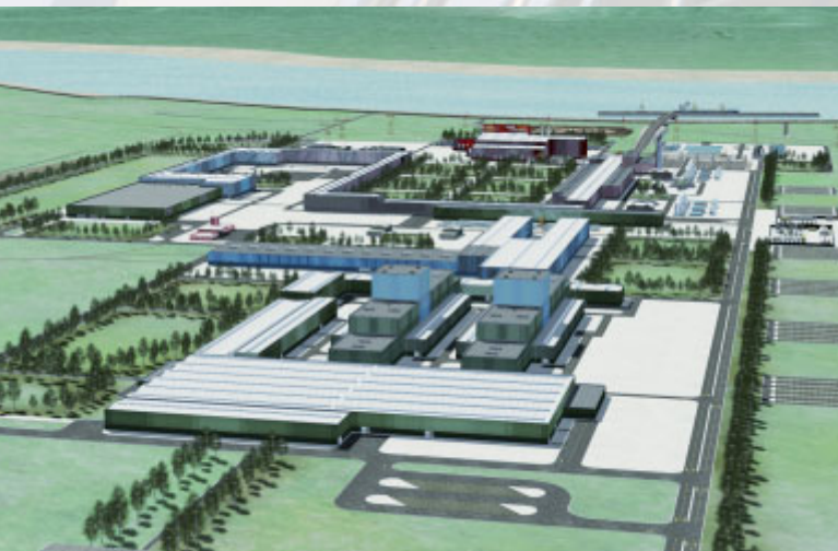
◀ Herzstück ist eine von ThyssenKrupp Steel und Stainless gemeinsam genutzte Warmbreitbandstraße mit einer Kapazität von 5,2 Millionen Tonnen. Sie wird ergänzt durch Kaltwalz- und Feuerbeschichtungsanlagen.
