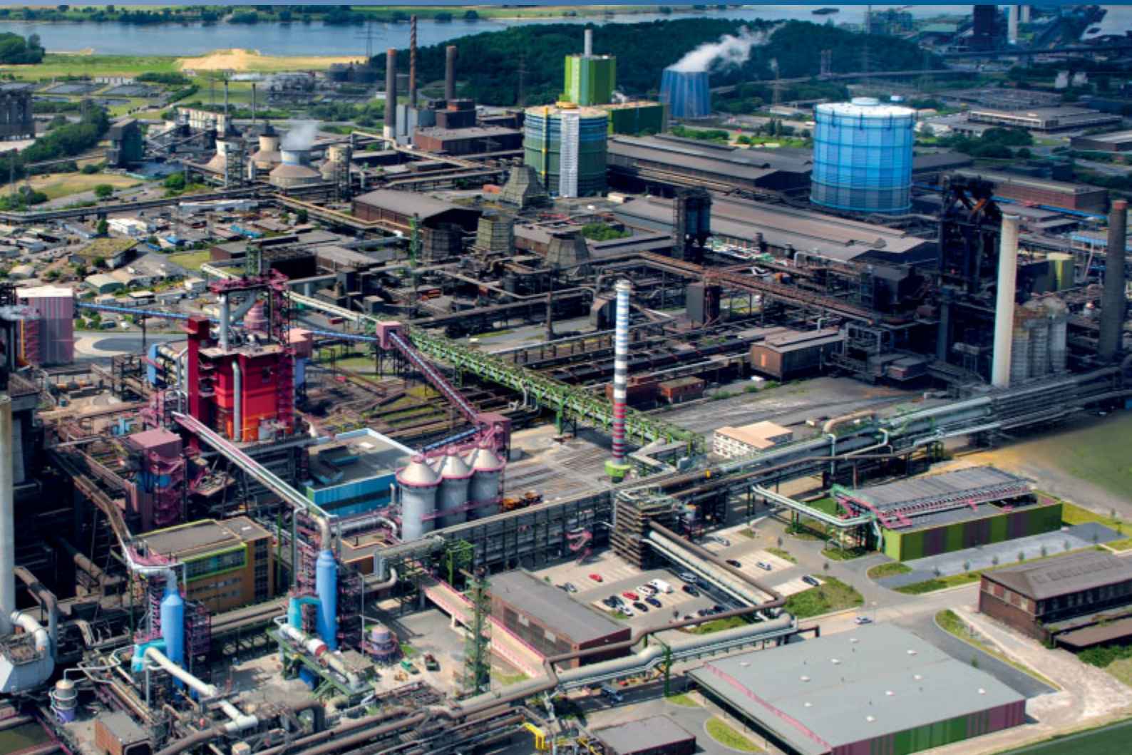
▲ Ein Labyrinth aus Rohren und Leitungen verteilt Abhitzedampf, der bei der Stahlproduktion entsteht. Damit werden die Beizbäder der Beschichtungsanlagen sowie die Büros beheizt.
