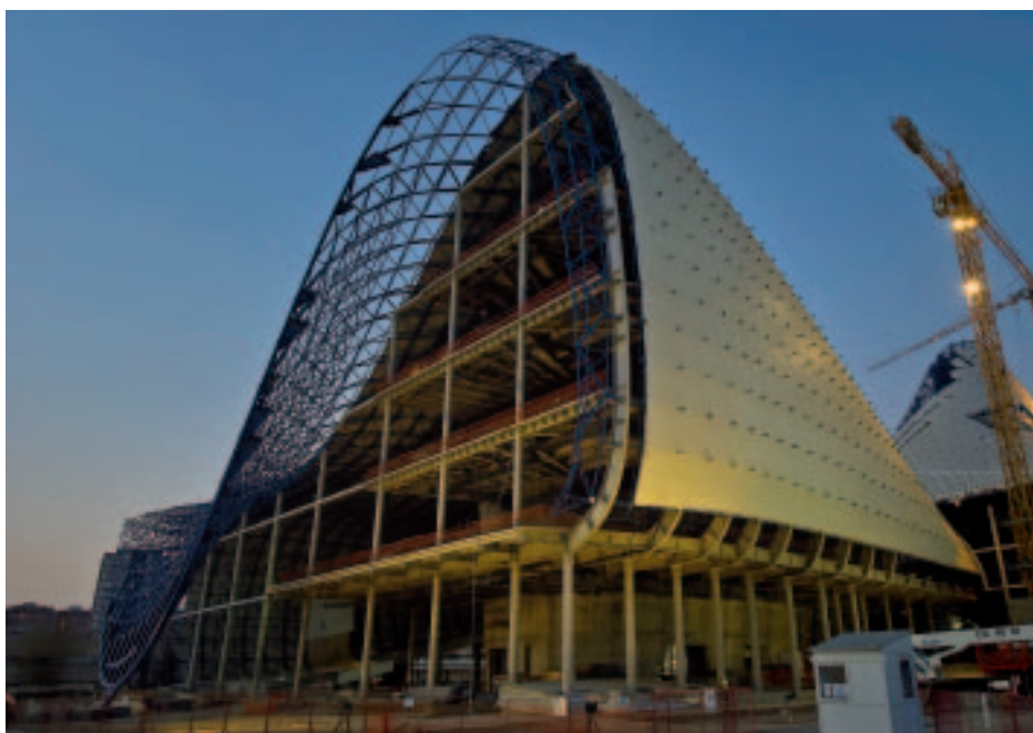
Die Hülle des Kongresszentrums Heydar Aliev in Baku besteht aus Profilen der Geschäftseinheit Color/Construction von ThyssenKrupp Steel Europe. Die mit einem grau-weißen Polyester-Überzug beschichteten Elemente sind auf einer fachwerkartigen stählernen Tragkonstruktion montiert und sind absolut witterungsbeständig: damit Baku lange was von seiner neuen Landmarke hat.
