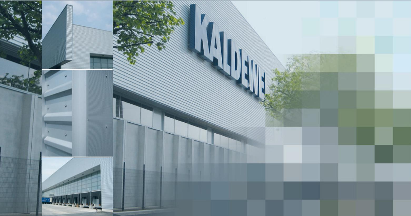
Der hohe gestalterische Anspruch des modernen Logistikzentrums mit Verwaltungstrakt zeigt sich besonders in der Gestaltung der Fassade mit ihren auskragenden Bauteilen und den verwendeten Hoesch® Trapezprofilen und Hoesch isorock® Sandwichpaneelen, beschichtet mit **ReflectionsLume® silver 1**. Das „farbige Silber“ verleiht ein technisch anmutendes Fassadenbild.
